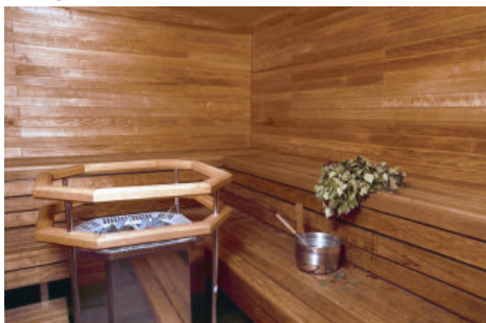
figuur 4-2 Toepassing ThermoWood in een sauna
