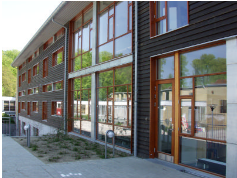
figuur 4-3, Toepassing ThermoWood in een gevel
